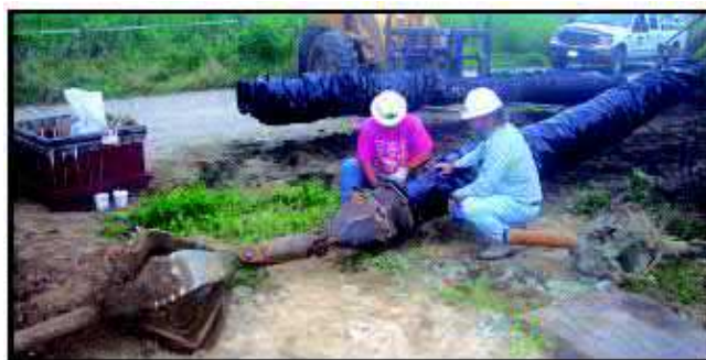
Рисунок 6.17 Прокладка трубопровода методом горизонтально направленного бурения.
