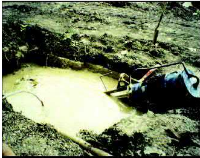
Рисунок 6.23 Входное отверстие для ГНБ и циркуляционный насос для бурового раствора.
