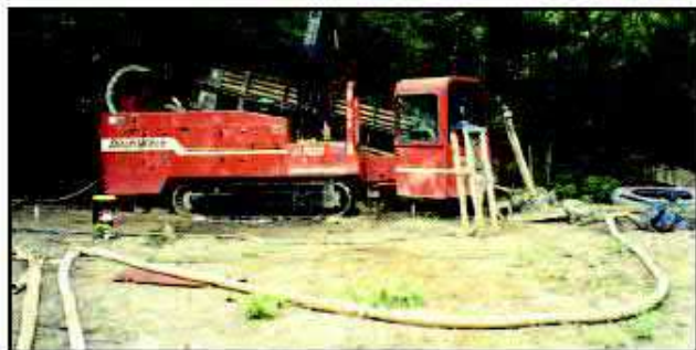
Рисунок 6.17 Прокладка трубопровода методом горизонтально направленного бурения.
