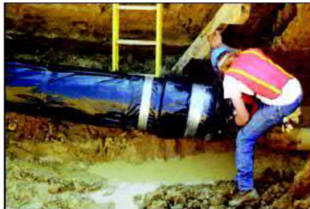
Рисунок 6.22 Покрытие труб полиэтиленовым рукавом.
