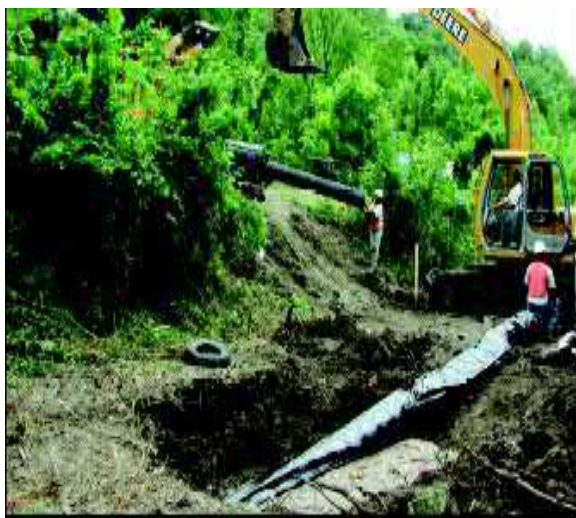
Рисунок 6.24 Картриджный метод укладки труб.
